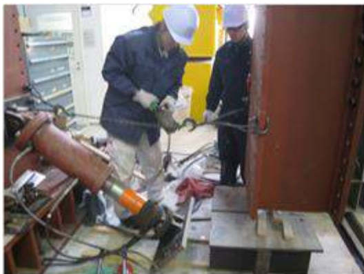
1. 水平ジャッキを取外す
