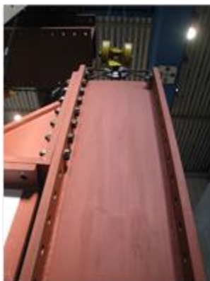
2. 梁についている治具を取外す
