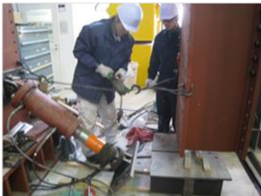
1. 水平ジャッキを取外す
