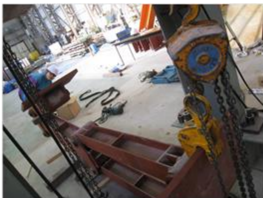
3. 梁の位置を調整しパンタグラフを外す
