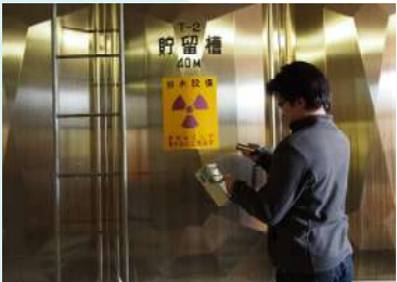
線量率の測定：貯留槽
