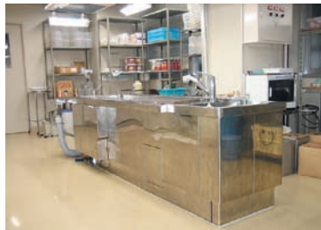
解剖処置：局所排気型解剖台
