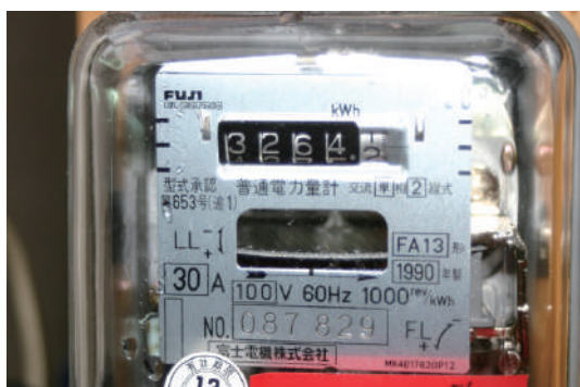
図 6. 電力計の設置
